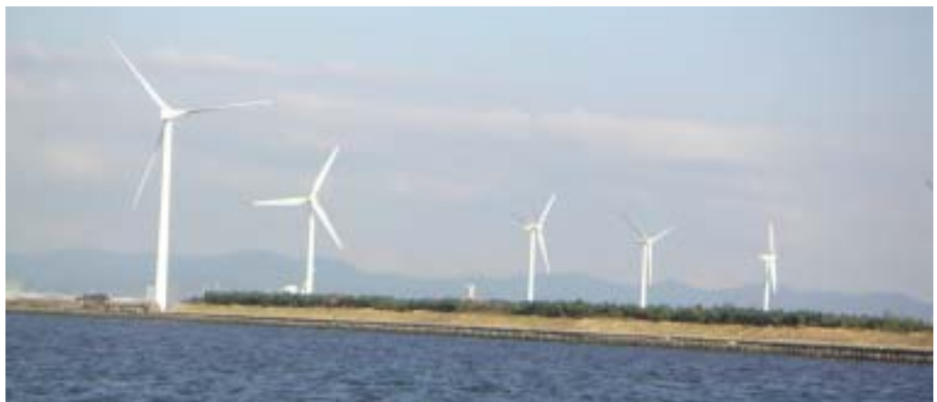
田原臨海部に建設が進む直径80mの風力発電施設（総数は12基に）
